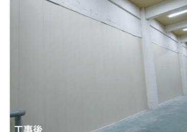
**改修中** 耐震壁の新設(1階・2階) 耐震性を増すために、鉄筋コンクリート造による耐震壁を作っています。
