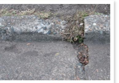
▲損傷したL型側溝:工事前
