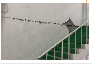
▲同配送センター1階管理棟の亀裂:工事前
