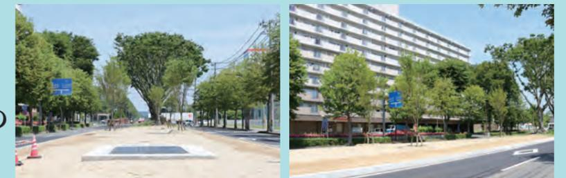
令和2年3月終了予定となっており、現在、東の杜大通り(卸町三丁目8-1地先)の片側一車線規制は解除されました。また、中央分離帯に整備されたシールドトンネル発進基地となる立坑が撤去され、基地整備のために街路樹を伐採した中央分離帯に新しい木が植栽されました。
