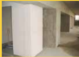
3F共用廊下外壁ALC取付状況
