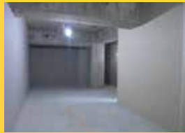
2Fテナント耐火間仕切壁施工状況
